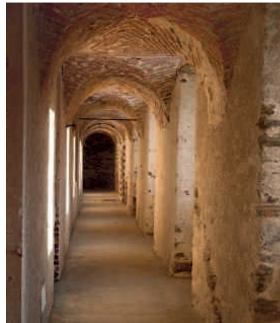
Nella pagina a fianco, la Trappa d'inverno. Qui sopra, interni dell'antico edificio (foto A.Molino)
