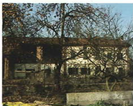
La Cascina Belvedere: futura sede della riserva.
