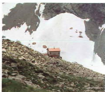
Rifugio "Morelli-Buzzi" (C.A.I. di Cuneo) nell'alto vallone di Lorusa sotto il colle del Chiapous
