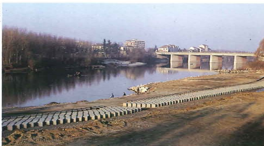
Le prismi contenendo le divagazioni dei fiumi li trasformano in canali e ne riducono le capacità autodepurative. Nella foto una lunga teoria di cubi di cemento sul Po a Casale.
