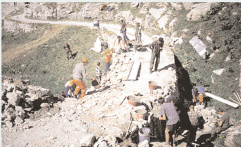
Operazione Alte Vie: rifacimento di un ponte (foto E. Elia)
