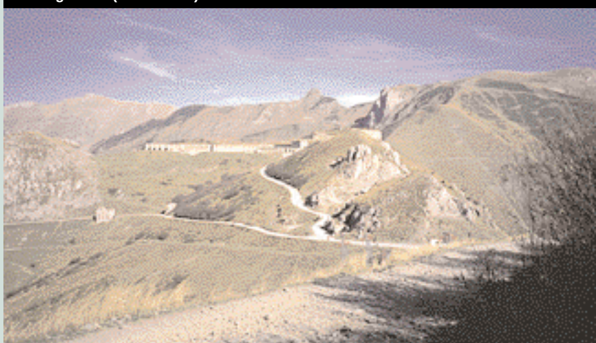
Il Col di Tenda con la caserma e il forte centrale (foto F. Dardanello)
