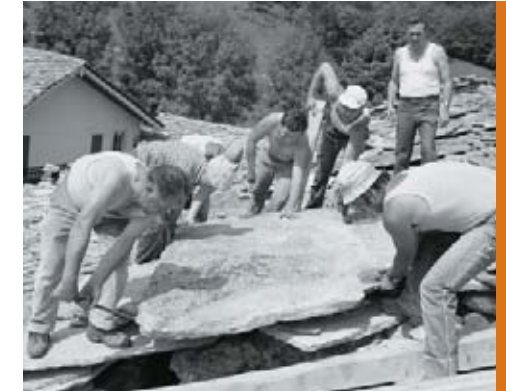
Lavori di rifacimento del tetto (Foto Gabriele Mariotti)
