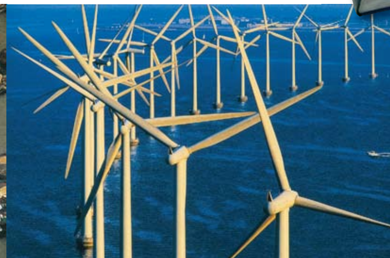
Parco eolico al largo di Copenaghen
